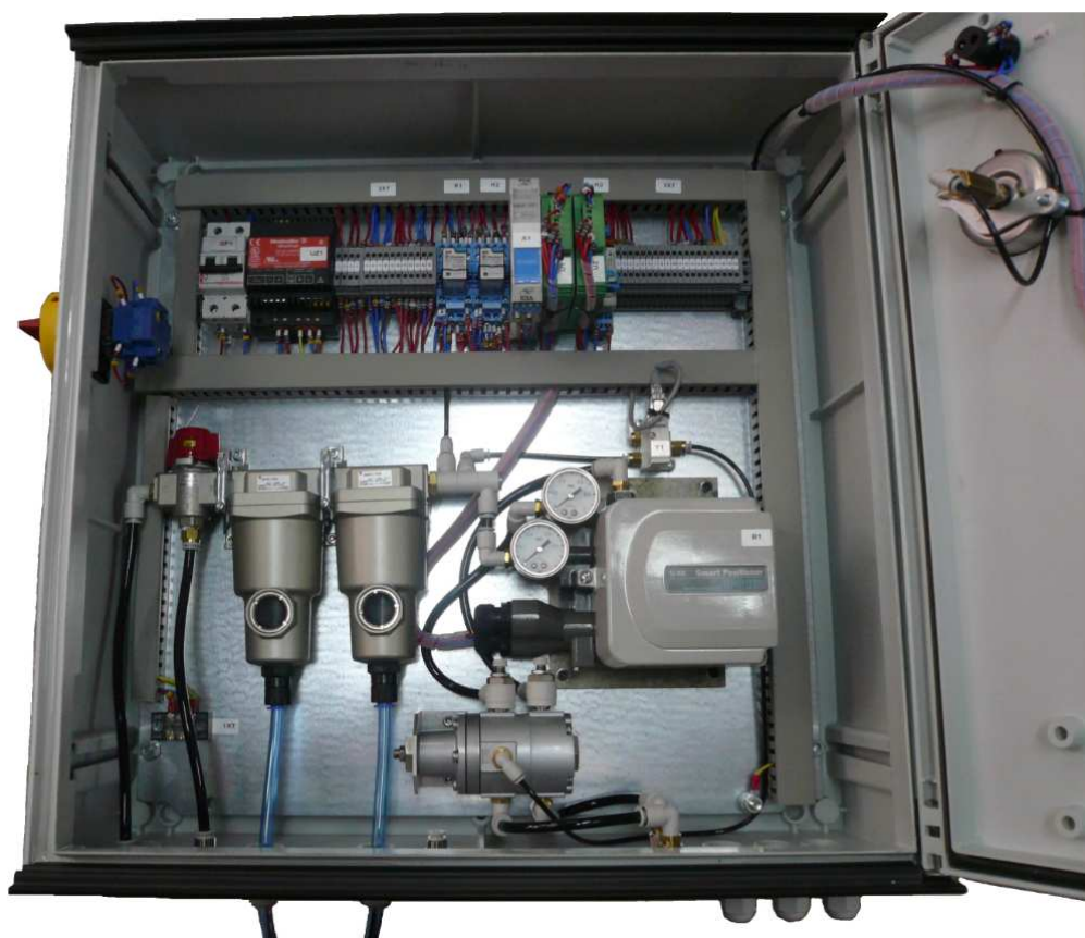
Рис. 8 Шкаф управления с установленным внутри позиционером IP8101
