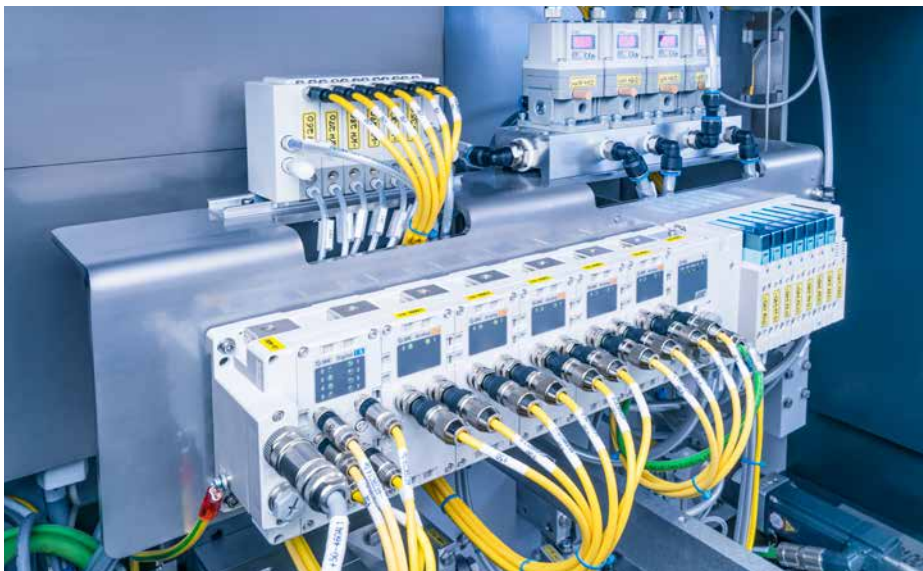
Bestens kontrolliert: Die Ventilinsel der Serie SY und Druckregler der Serie ITV von SMC bringen Druckluft dorthin, wo sie benötigt wird.
