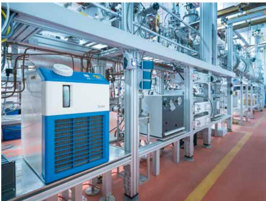
Das Temperiergerät HRS018 von SMC leistet bereits 45 000 Betriebsstunden ohne Wartung und ohne Störung. (© TU Darmstadt)
