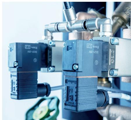
Redundanter Aufbau der Sicherheitsventile.
